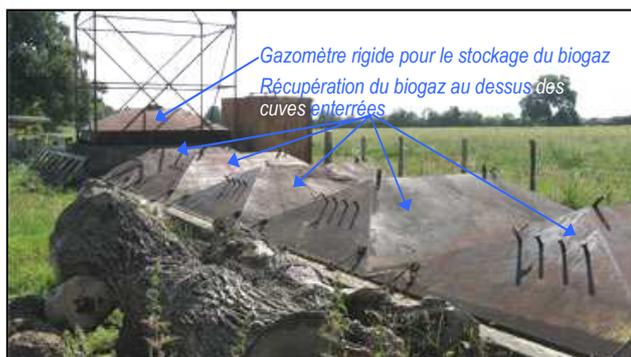
*L'immersion complète nécessite la mise en place d'un système de rétention des matières immergées car elles flottent naturellement : ce système doit être capable de résister à des contraintes mécaniques élevées.*
