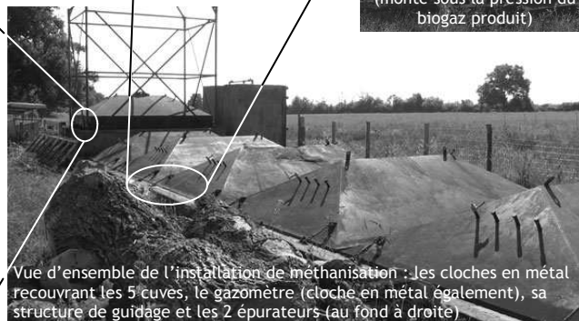
Épurateurs et gazomètre (monte sous la pression du biogaz produit)
